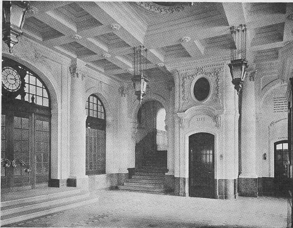
Abb. 7. Eingangshalle im Erdgeschoss.
