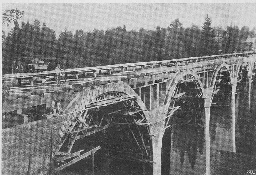
Abb. 9. Aufmauern der Verkleidungswände, Versetzen der Siegwartbalken. 3. IX. 1912.
