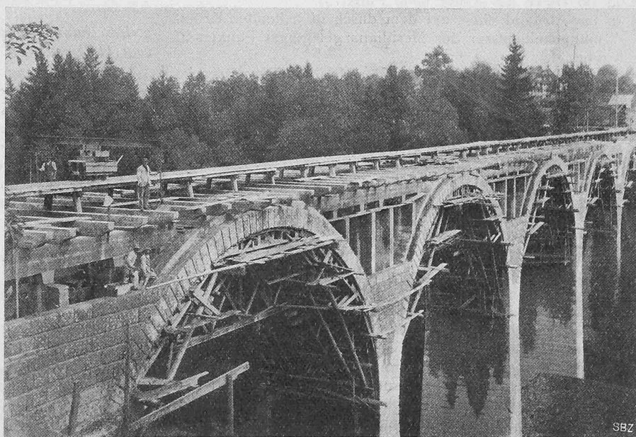
Abb. 9. Aufmauern der Verkleidungswände, Versetzen der Siegwartbalken. 3. IX. 1912.
