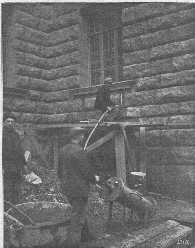
Wiederherstellung des gerissenen Mauerwerks durch Mörtel­ein­pres­sen mittels Handapparats am neuen Stadthause an der Klosterstraße in Berlin.
