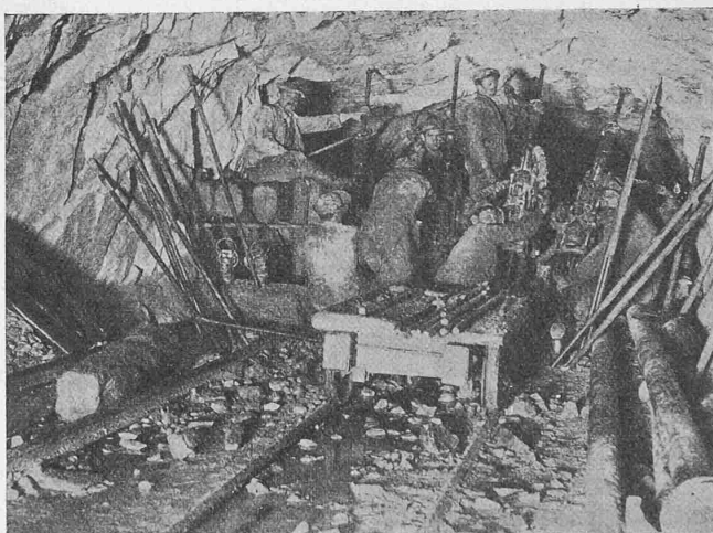
Auffristen des Sohlenstollens im Lötschbergtunnel, Nordseite, Km. 6,300. Aufnahme vom Mai 1911 von Ing. A. Ratjen.
