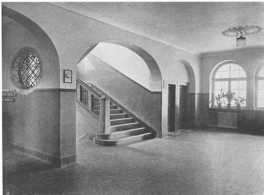
Speisesaal und Treppenvorplatz im Erdgeschoss
