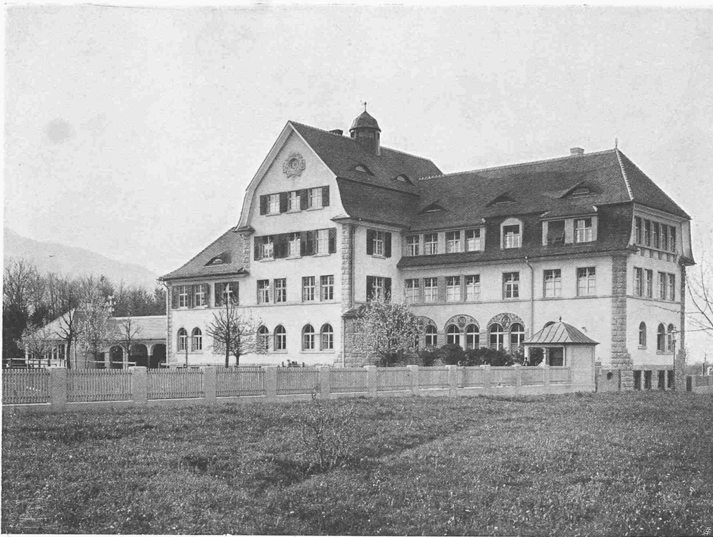
Gesamtbild von Südost
