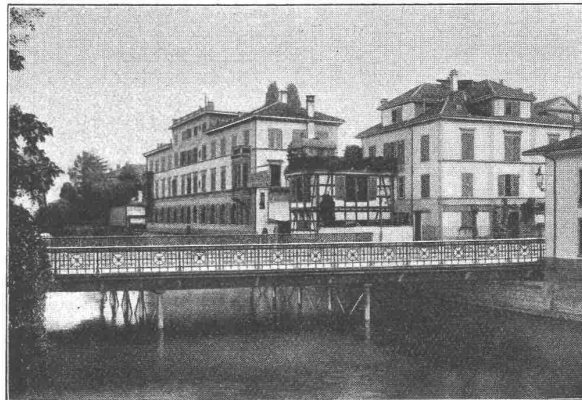
Dreikönigsbrücke in Zürich. Eisengewicht 99,8 Tonnen.
