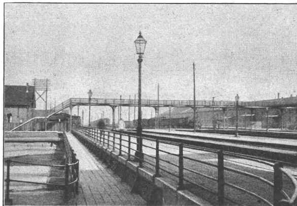
Passerelle Hauptbahnhof Zürich. Eisengewicht 28 Tonnen.
