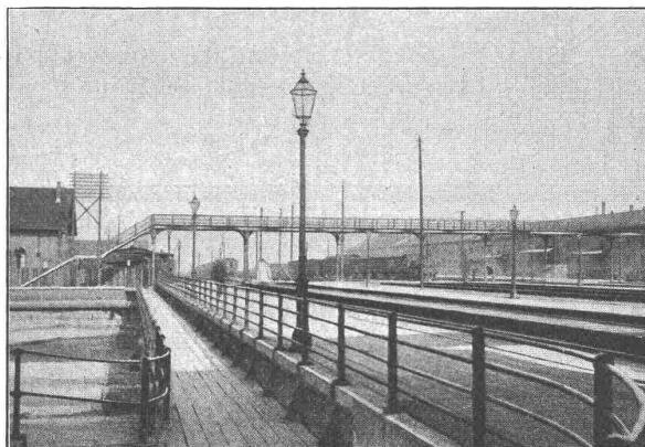
Passerelle Hauptbahnhof Zürich, Eisengewicht 28 Tonnen.
