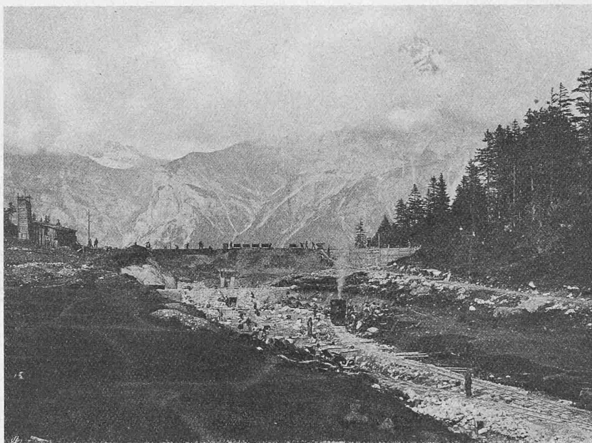
Abb. 17. Vertiefung der Weihersohle gegen den Ostdamm hin.
