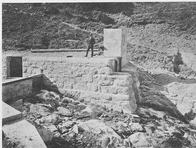
Abb. 8. Wasserfassung des Intschialpbaches.
