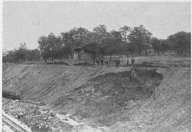
Abb. 1. Einschnitt-Rutschung bei Km. 17,500 der B. T.
