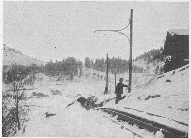
Abb. 27. Senkung des Bahnkörpers bei Km. 3,0.
