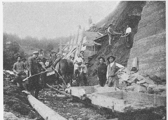
Abb. 10 u. 11. Materialtransport durch Schlitten.
