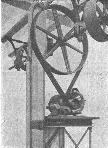
Die Abbildung zeigt den Antrieb einer Transmission durch einen Elektromotor mittels „Lenix“.
