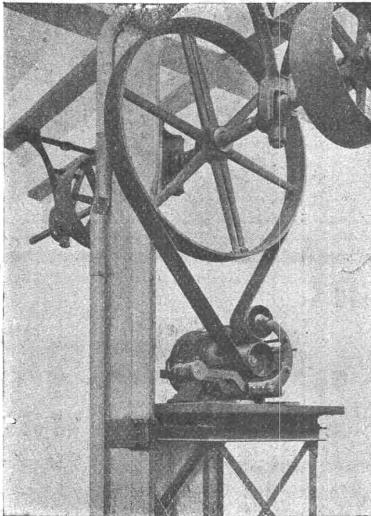
Die Abbildung zeigt den Antrieb einer Transmission durch einen Elektromotor mittels „Lenix“.
