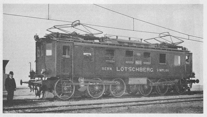
Abb. 19. Lötschberg-Lokomotive Nr. 121, gebaut von der Maschinenfabrik Oerlikon und der Schweiz. Lokomotiv- und Maschinenfabrik Winterthur.
