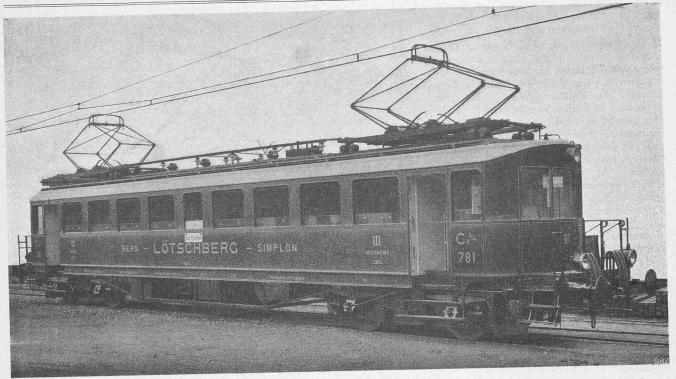
Abb. 5. Seitenausicht des Motorwagens gebaut von den Siemens-Schuckert-Werken und der Waggonfabrik Schlieren
