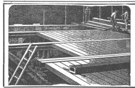
bestehend aus einzelnen, fabrikmässig hergestellten Zement-Hohlhalken, mit armierten Seitenwandungen für beliebige Spannweiten bis 6,50 m
