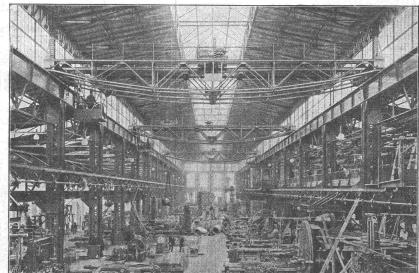
3 elektrisch betriebene Laufkrane, 40000 und 10000 kg Tragfähigkeit, 18,7 m Spannweite, Skodawerke A.-G., Pilsen.
