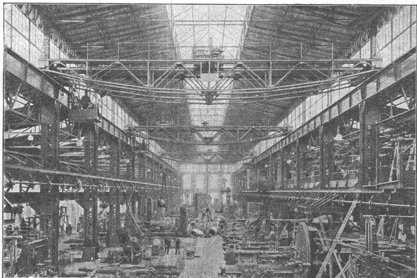
3 elektrisch betriebene Laufkrane, 40000 und 10000 kg Tragfähigkeit, 18,7 m Spannweite, Skodawerke A.-G., Pilsen.
