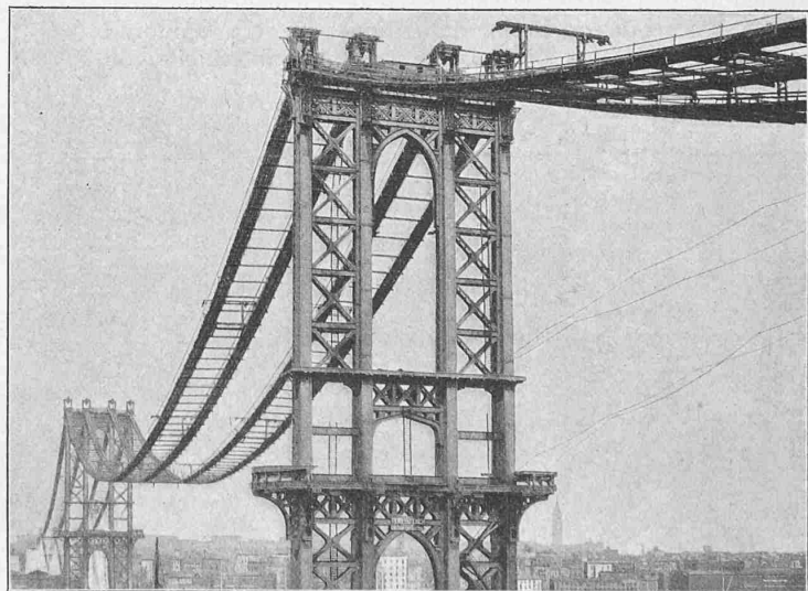
Abb. 28. Montage-Hängebühnen der Manhattanbrücke. (Aus «Eisenbau».)
