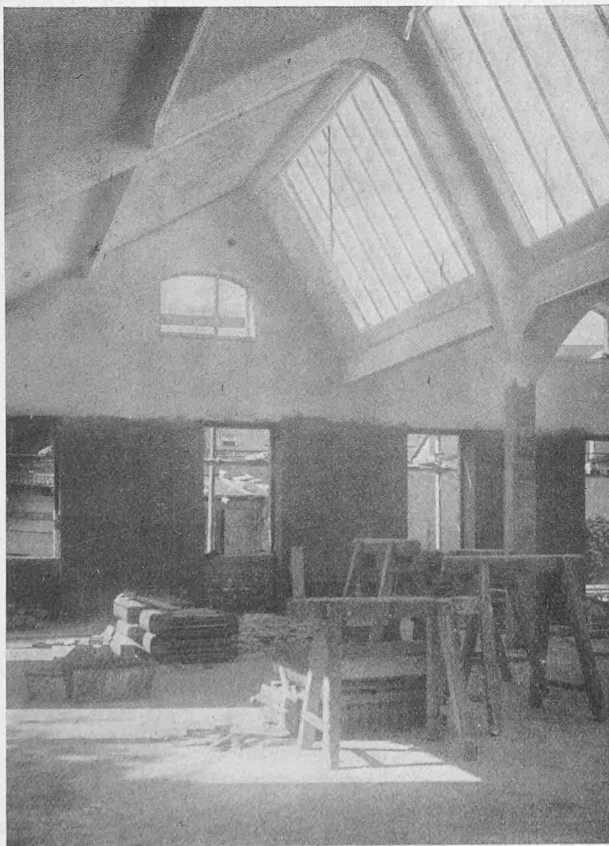
Abb. 2. Untersicht des Sheddaches mit Oberlicht.
