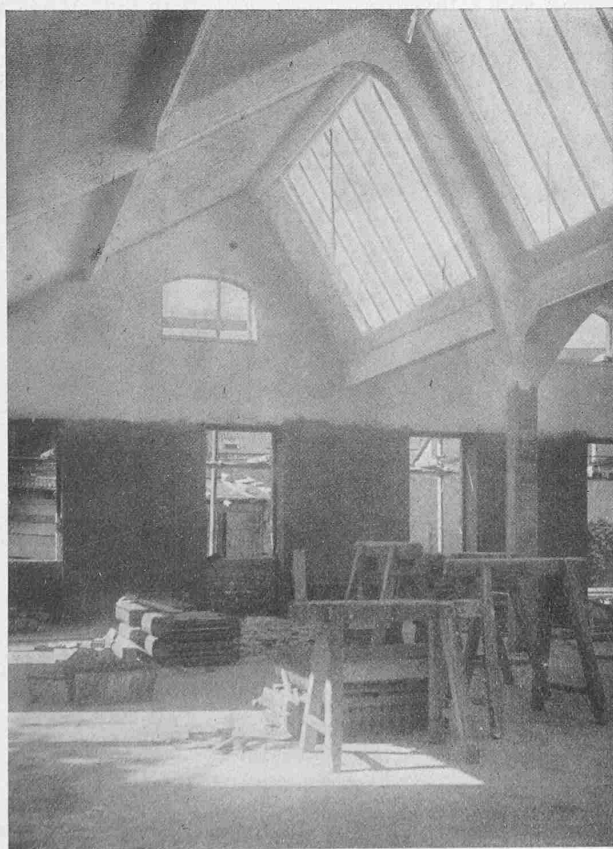
Abb. 2. Untersicht des Sheddaches mit Oberlicht.
