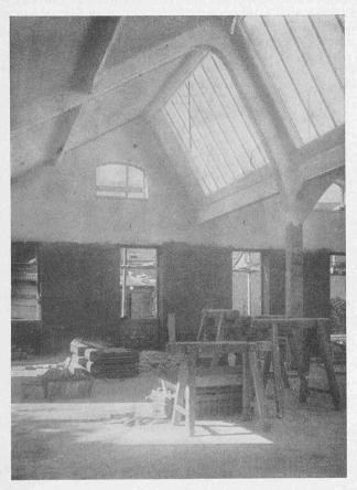
Abb. 2. Untersicht des Sheddaches mit Oberlicht.
