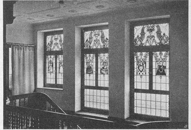
Abb. 8. Bunte Fenster der Halle im Obergeschoss.
