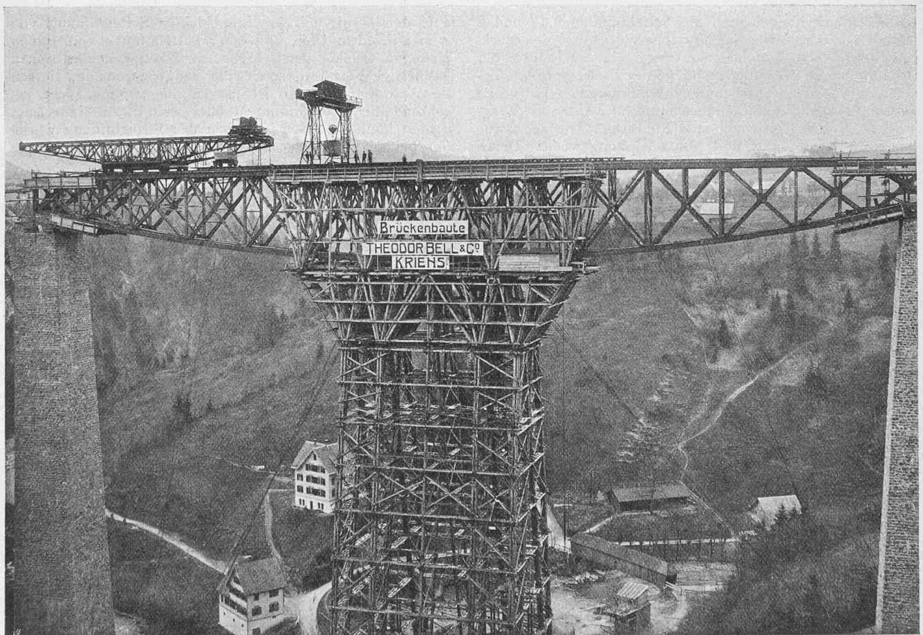
Abb. 19. Oberer Teil des Gerüstturms mit Hubkran und Auslegerkran zum freien Vorbau des Eisenträgers des Sitterviadukts der B. T.
