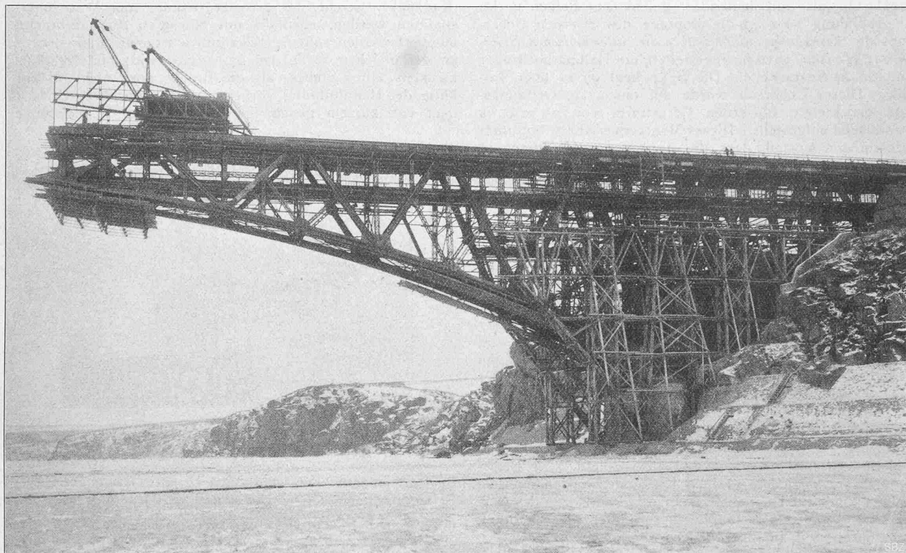
Abb. 18. Freies Vorbauen der Eisenbahn- und Strassenbrücke über den Dnjepr bei Alexandrowsk (Südrussland).
