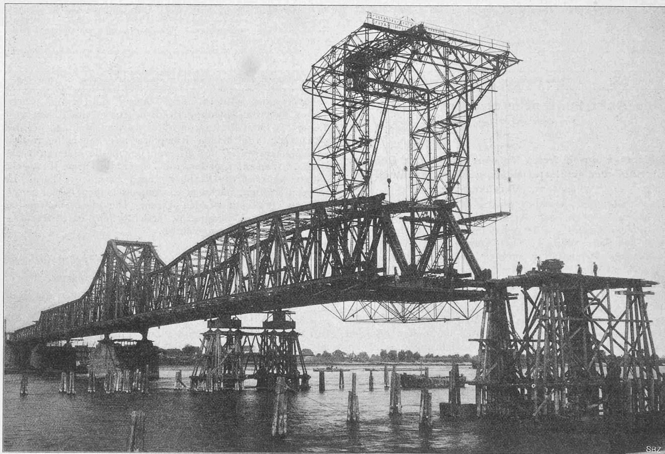
Abb. 16. Freies Vorbauen des mittlern Ueberbaues der Ruhrort-Homberger Strassenbrücke über den Rhein.
