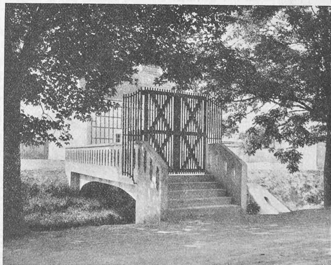
Abb. 4. Eulachbrücke, Zugang zum Maschinenhaus.
