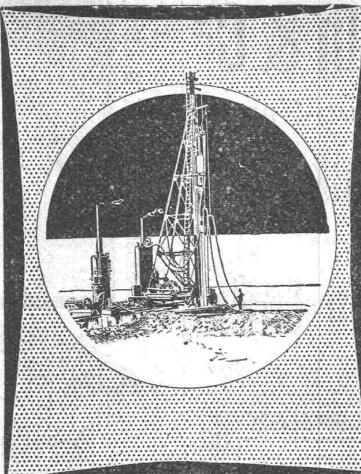
Eine Universal-Betonpfahl-Ramme mit Dampfbär von 2400 kg wird gegenwärtig für die Fundationsarbeiten des Gebäudes der Schweizerischen Rückversicherungs-Gesellschaft beim Belvoir-Park Zürich-Enge verwendet.
