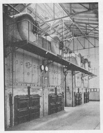
Abb. 11. Wasserrohrkessel-Anlage des Elektr.-Werkes Kubel.
