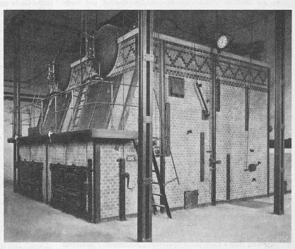
Abb. 10. Wasserrohrkessel-Anlage des Elektr.-Werkes der Stadt Winterthur.
