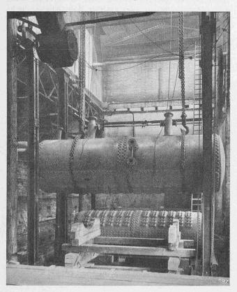
Abb. 18. Montage eines Garbekessels.
