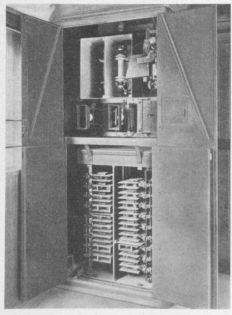
Abb. 18. Hochspannungskammer mit Kontroller des Motorwagens.
