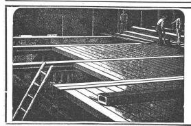
bestehend aus einzelnen, fabrikmässig hergestellten Zement-Hohlbalken, mit armierten Seitenwandungen für beliebige Spannweiten bis 6,50 m
