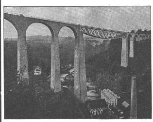
Sitterbrücke 900 Tonnen mit teilweise abgebrochenem Montagegerüst. Siützweite 120 m. Montagehöhe 100 m.
