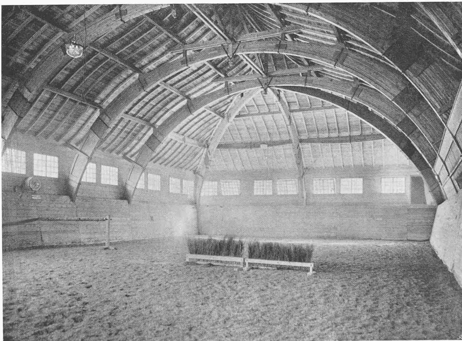
Hetzer-Konstruktion von TERNER & CHOPARD, Ingenieur-Bureau Zürich
