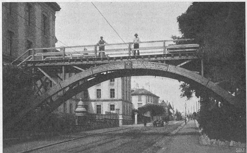
Abb. 2. Provisorischer Fussgängersteg in Beaulieu bei Lausanne.
