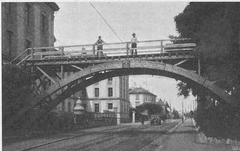
Abb. 2. Provisorischer Fussgängersteg in Beaulieu bei Lausanne.
