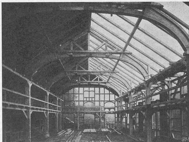
Abb. 15. Hetzersche Fachwerk-Binder, Turnhalle Ziegenrück.
