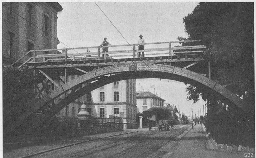
Abb. 2. Provisorischer Fussgängersteg in Beaulieu bei Lausanne.
