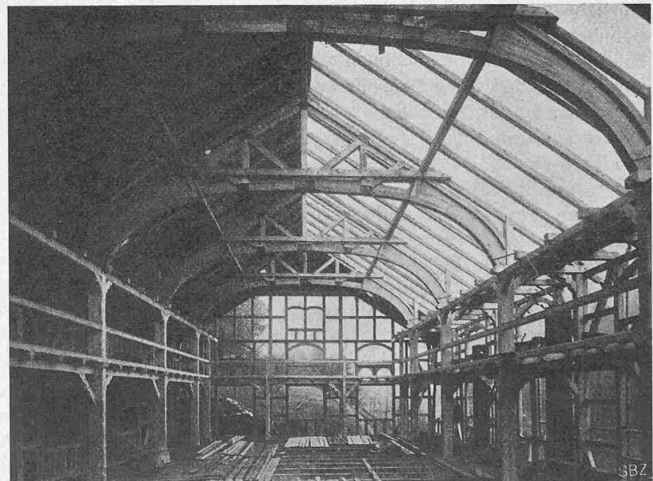
Abb. 15. Hetzersche Fachwerk-Binder, Turnhalle Ziegenrück.
