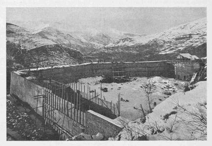
Abb. 31. Ausgleichbecken für die Zentrale Cedegolo, in Ausführung begriffen.
