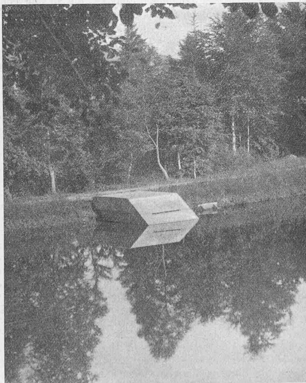
Abb. 14. Einlauf des Saugüberfalls in Gibswil.
