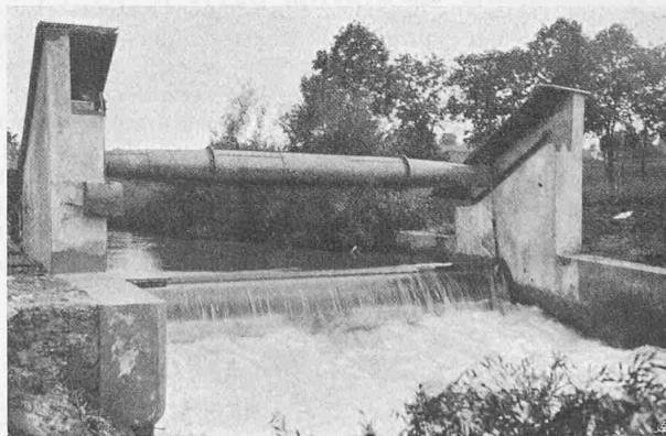
Abb. 2. Automatische Klappe in Sirnach bei Ueberflutung.
