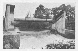
Abb. 2. Automatische Klappe in Sirnach bei Ueberflutung.
