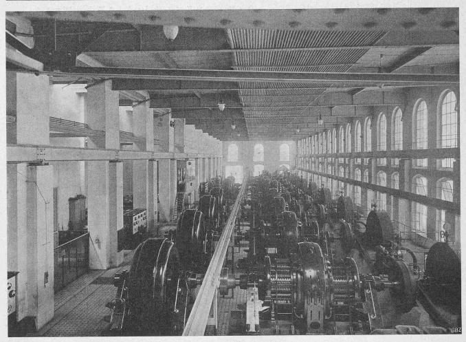
Abb. 28. Kraftzentrale der Navizance-Anlage in Chippis der Aluminium-Industrie-A.-G. Neuhausen (rechts die Turbinen).
