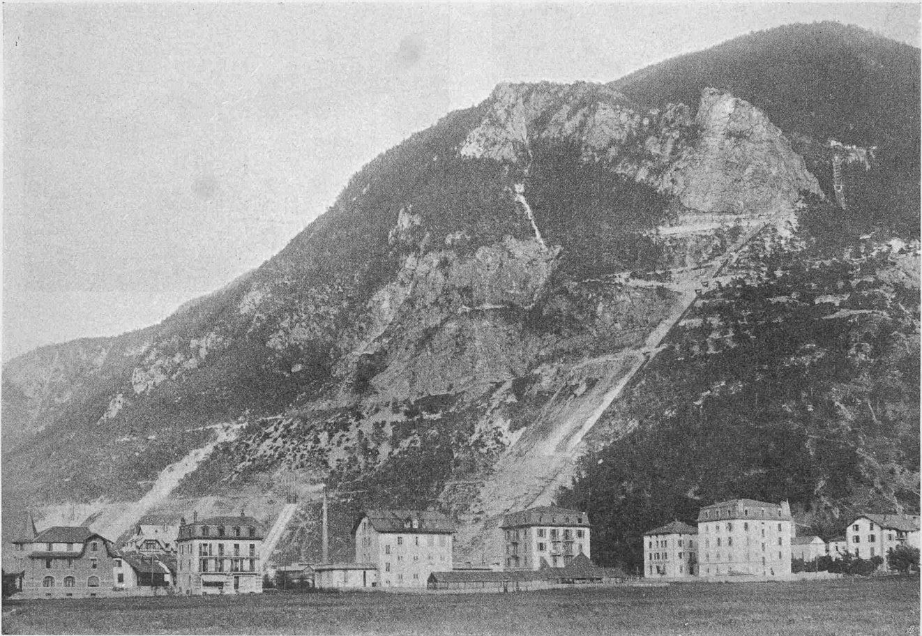
Abb. 15. Uebersicht der ganzen Navizance-Druckleitung (rechts); Druckleitung des Rhone-Werkes mit Standrohren (links).
