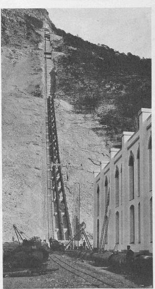
Abb. 18. Unterer Teil der Druckleitung und Maschinenhaus.
