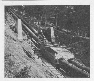
Abb. 17. Verankerungspunkt II im Bau.
