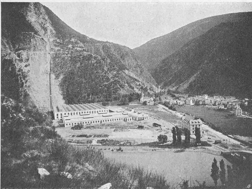
Abb. 19. Blick aus Nordwest auf das Fabrikareal und das Dorf Chippis.
