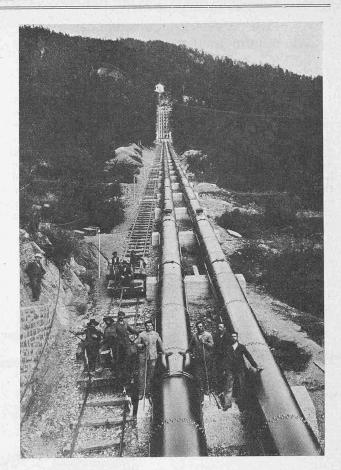
Abb. 16. Wasserschloss und oberer Teil der Druckleitung.
