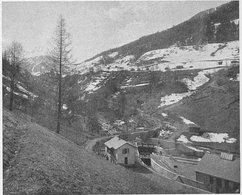
Abb. 3. Gesamtansicht der Wasserfassung bei Vissoye.
