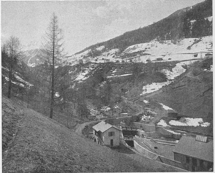
Abb. 3. Gesamtansicht der Wasserfassung bei Vissoye.
