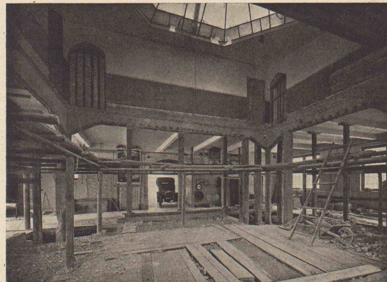
14. Utogarage in Zürich V. Ausstellungshalle. Verstärkung bereits ausgeführter Eisenbetonkonstruktion
