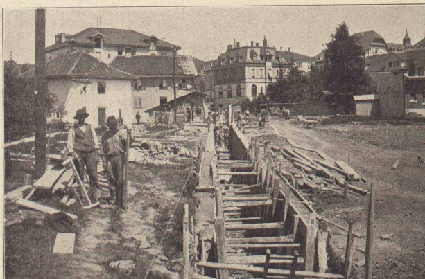
11. Kanalisation in Wil (Kt. St. Gallen). Ueberdeckung und Brücken aus Eisenbeton
