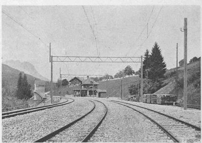
Abb. 9. Fahrleitung und Schalterhäuschen auf Station Heustrich.
