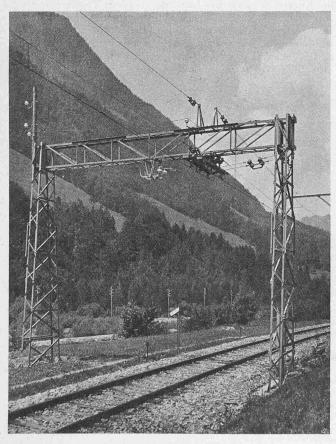
Abb. 7. Streckentrennung und Fixpunkt bei Station Heustrich.
