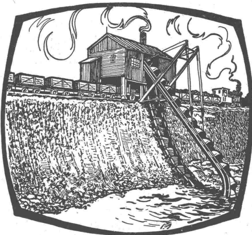
3 Löffelbagger } z. Zeit in der Schweiz 2 Eimerkettenbagger } im Betrieb.
