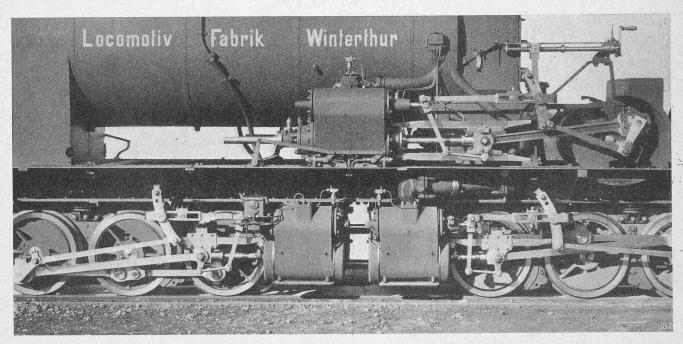
Abb. 6. Die Schneeschleudermaschine der Berninabahn. — Detail der Triebwerks-Anordnung.
