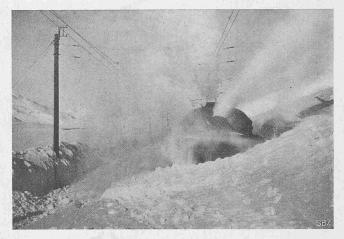
Abb. 2. Schneeschleudermaschine im Gang, von vorn.
