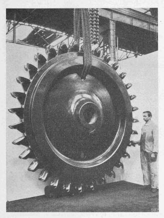
Abb. 18. Laufrad der Turbine von 6500 PS.
