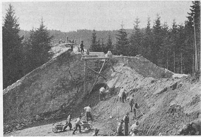
Abb. 17. Rückseite der gerissenen Flügelmauer links (Abb. 16).
