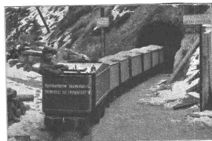
Stollenbau der Wasserleitung Göstling.
