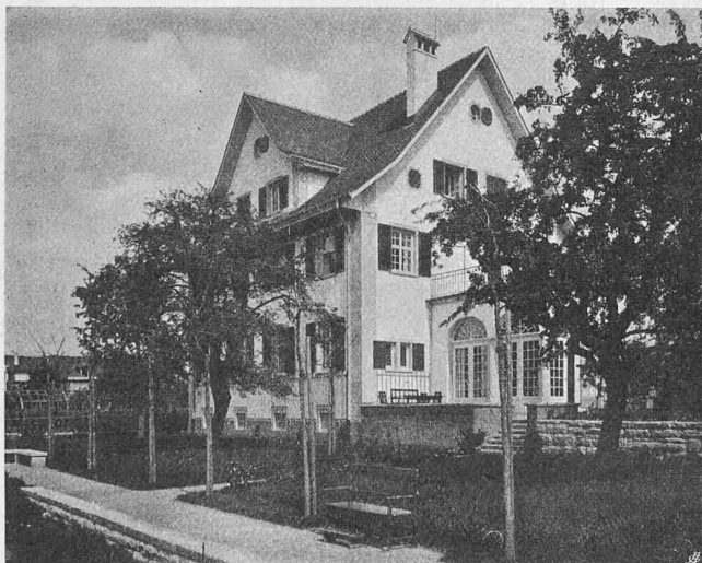
Abb. 6. Ansicht von Süden.
