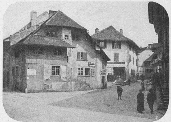
Baustelle für das neue Post- und Telegraphengebäude Murten.
