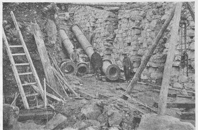
Abb. 13. Fundamente im Fixpunkt I bei der Zentrale.
