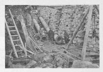
Abb. 13. Fundamente im Fixpunkt I bei der Zentrale.
