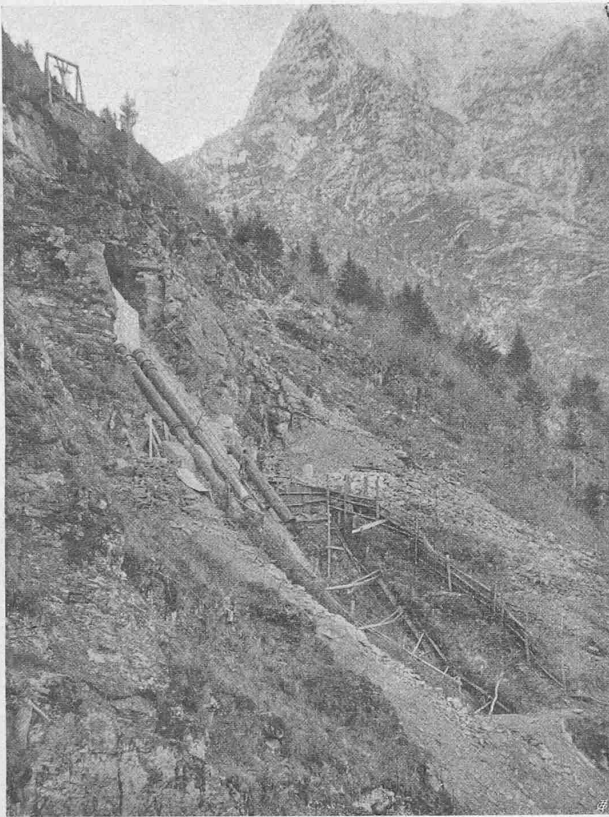
Abb. 10. Rohrleitung unterhalb Fixpunkt III.
