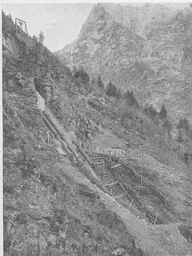
Abb. 10. Rohrleitung unterhalb Fixpunkt III.
