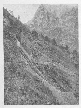
Abb. 10. Rohrleitung unterhalb Fixpunkt III.
