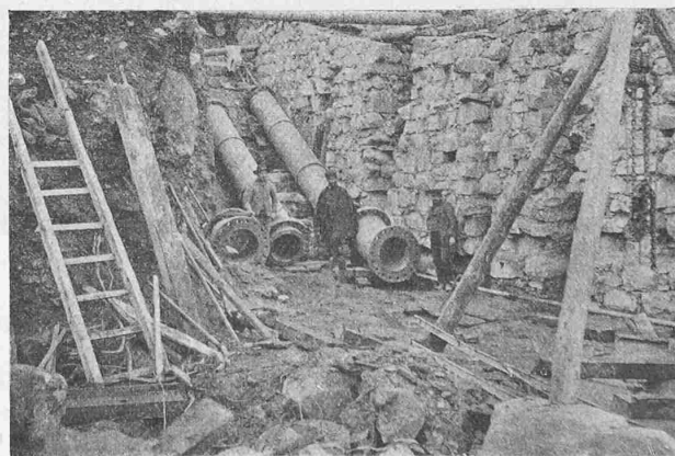
Abb. 13. Fundamente im Fixpunkt I bei der Zentrale.
